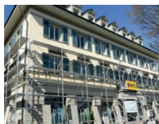
Umbau Verwaltungsgebäude. Seite 3
